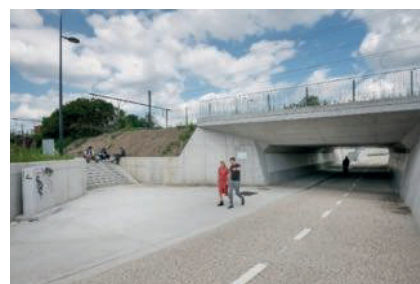
Unterführung mit Geh- und Radweg
