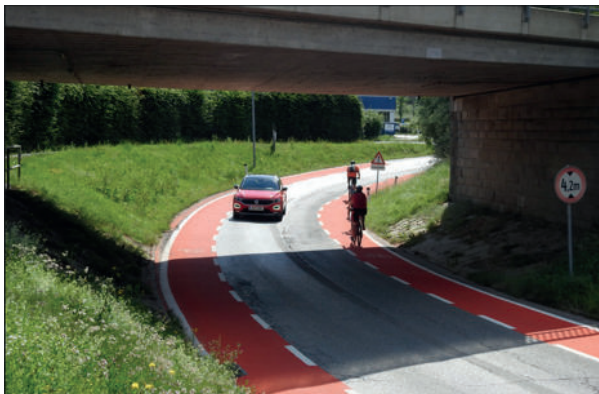
Referenzbeispiel eines Mehrzweckstreifens in Gratkorn / Harter Straße: Quelle: https://www.meinbezirk.at/graz-umgebung/c-lokales/roter-fahrbahn-erregt-aufmerksamkeit_a4118097
