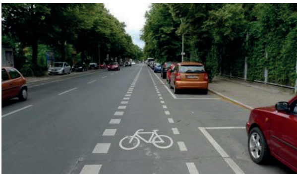
Vergleichbare Absetzung eines Radstreifens von Kfz-Parkstreifen in Berlin: https://www.radlobby.at/oesterreich/toedliche-radunfaelle-durch-dooring-gegenmassnahmen-noetig
