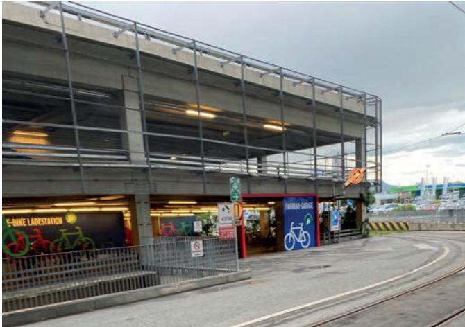
Teil eines Parkhauses: Fahrradgarage beim Murpark
