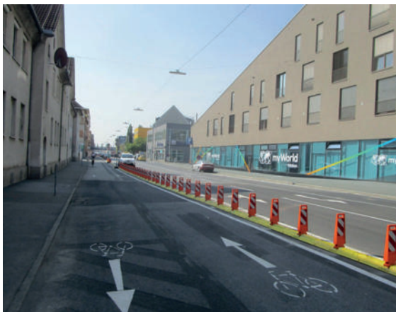
Beispiel Provisorischer Radweg, Alte Poststraße: https://grazer.at/de/90ed2HPQ/radinfrastruktur-zwei-neue-radweg-teile-fuer-die/?q=dom
