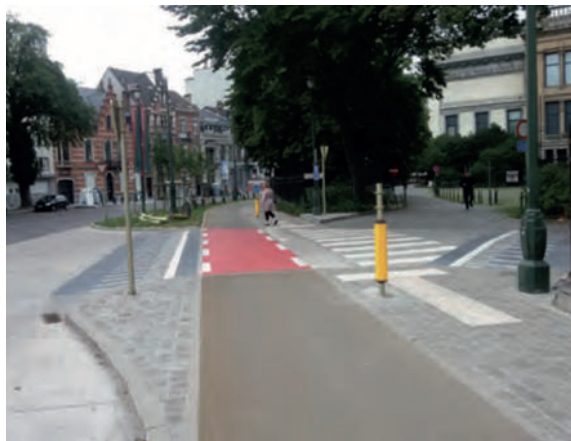
Abbildung 8: Rote Markierung von Gefahrenstellen, Brüssel
