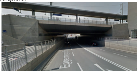
Unterführung Eggenberger Gürtel beim Hauptbahnhof
